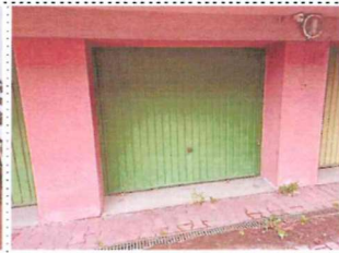
Pohľad na garáž
