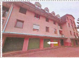
Celkový pohľad na dom- severovýchodný
