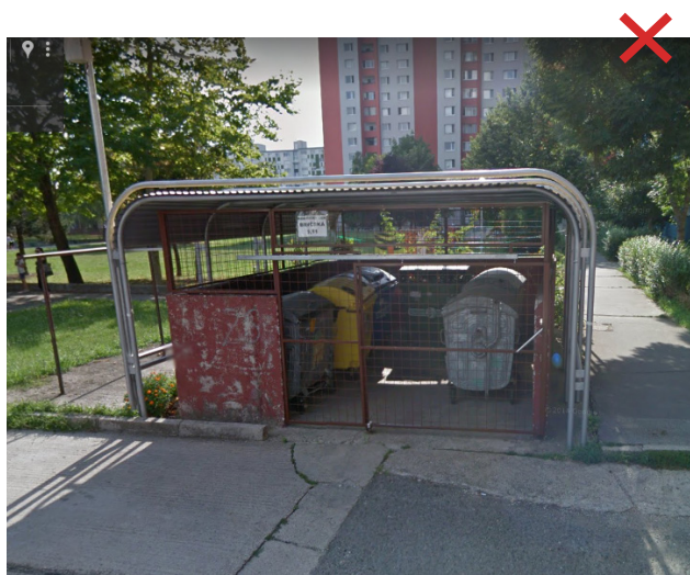
iný príklad statovišťa vyžadujúceho rekonštrukciu Ulica Miletičova
