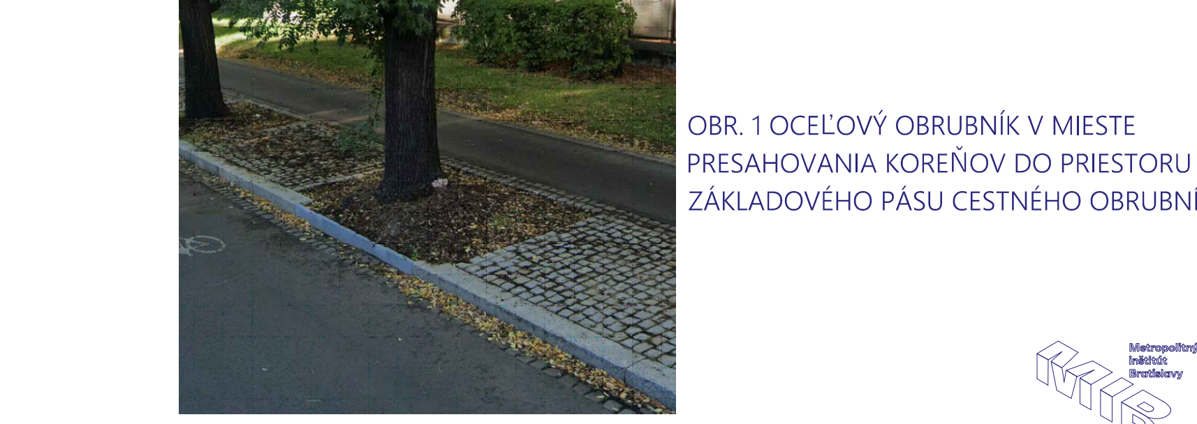
OBR. 1 OCEĽOVÝ OBRUBNÍK V MIESTE PRESAHOVANIA KOREŇOV DO PRIESTORU ZÁKLADOVÉHO PÁSU CESTNÉHO OBRUBNÍKA
