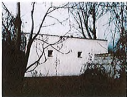
Pozemok parc.č. 15425/40 s okolím zastavaný stavbou s.p.č. 382, , pozemok je vnorený do parc.č. 15425/60, pohľad od
