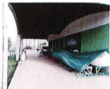
Stavbu súp.č. 382 na parc.č. 15425/41, pohľad od juhu
