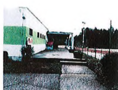
Pohľad na stavbu súp.č. 382 na parc.č. 15425/41 a ihrisko - parc.č.15425/63, pohľad od severu
