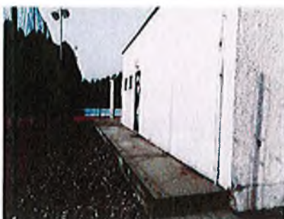
Stavbu súp.č. 382 na parc.č. 15425/41 a oplotenie ihriska na parc.č.15425/64, pohľad od východu
