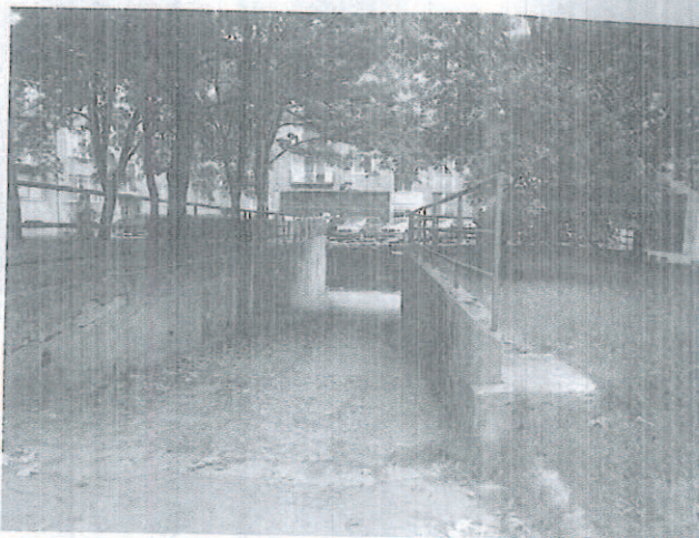
Vjazd ku garážam
