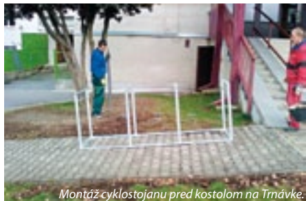
Montáž cyklostojanu pred kostolom na Trnávke.
