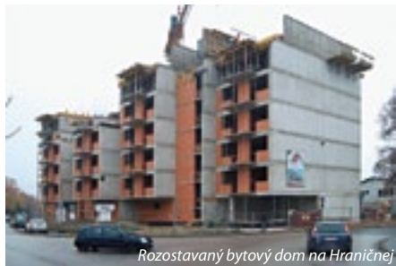
Rozostavaný bytový dom na Hraničnej
