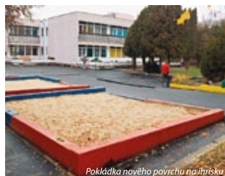
Pokládka nového povrchu na ihrisku
