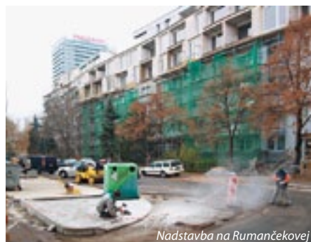
Nadstavba na Rumančekovej
