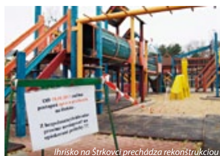
Ihrisko na Štrkovci prechádza rekonštrukciou
