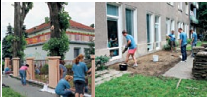
V materskej škole na Šťastnej ulici maľovali murované stĺpiky a plot okolo škôlky, ktorý má približne pol kilometra.
