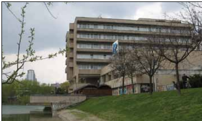
Vlastník hotela chce zastaraný objekt zbúrať a nahradiť ho kvalitnejšou novostavbou.
