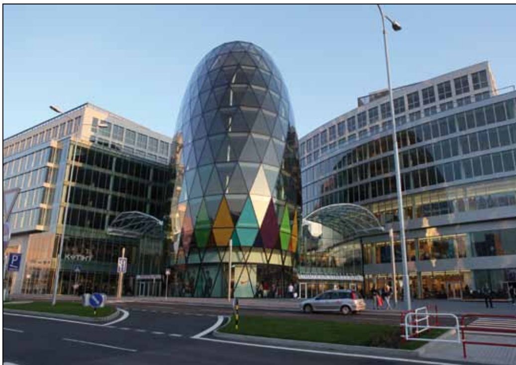
Budova „vajčko“ pri vchode do obchodnej galérie.
