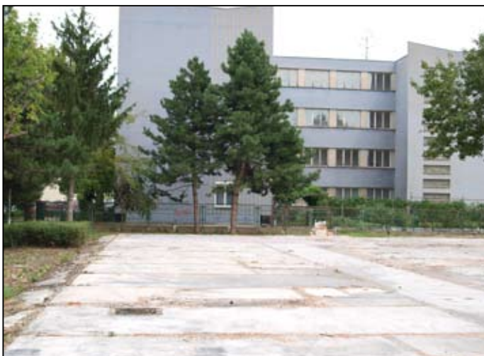
Po odstraňovaní ostala pri základnej škole vyčistená betónová doska.
