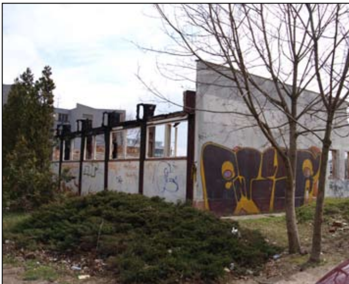
Takto vyzerala budova športovej haly vedľa základnej školy na Borodáčovej ulici potom, ako ju zničil požiar.
