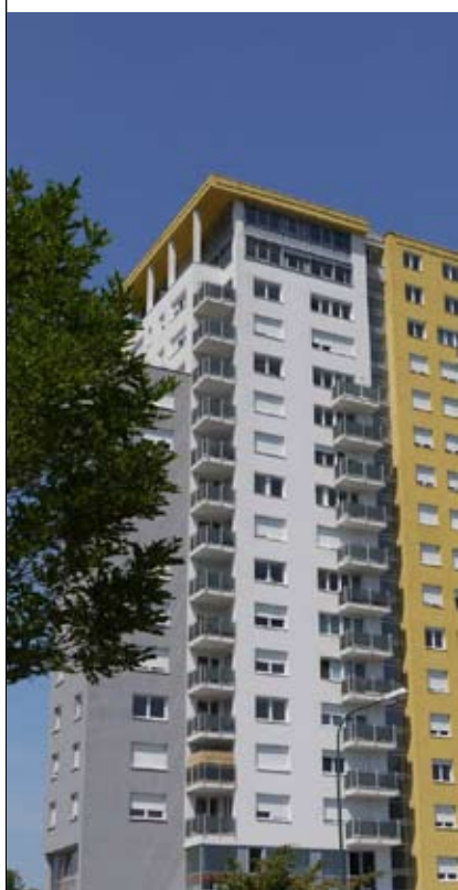
vykurovaný obytný dom Karolína
