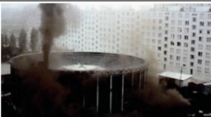
Fotografia centrálnej kotelne sídliska Trávniky na Pažitkovej v roku 1964. Na snímke je v plnej prevádzke na začiatku vykurovacieho obdobia na jeseň 1964. Kotelňa bola neskôr prestavaná na predajňu komisionálneho a zlacneného tovaru Rotunda. Po ďalšej nadstavbe slúži ako sídlo SARIO a pizzerie Rotunda. Snímku nafotil Július Puškáš.
