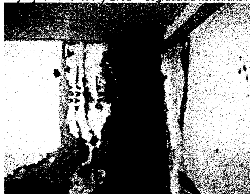
Chýbajúci kanalizačný zvod – degradácia konštrukcií
