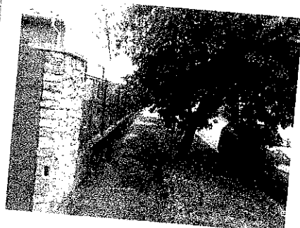
Hranica pozemku, pohľad od SV, oplotenie od ulice
