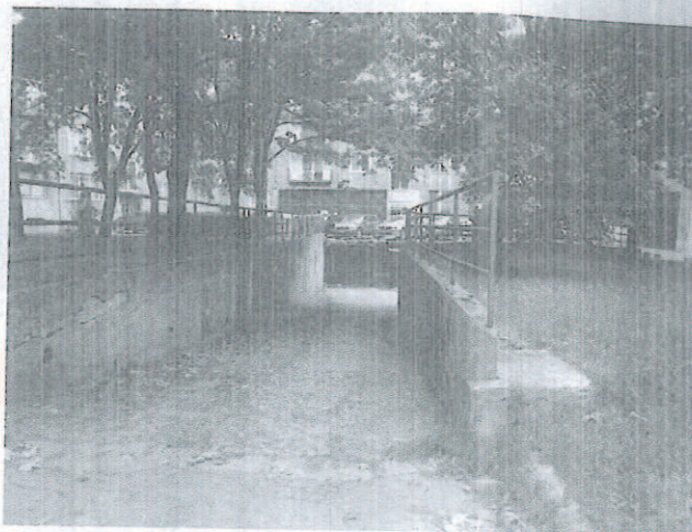
Vjazd ku garážam
