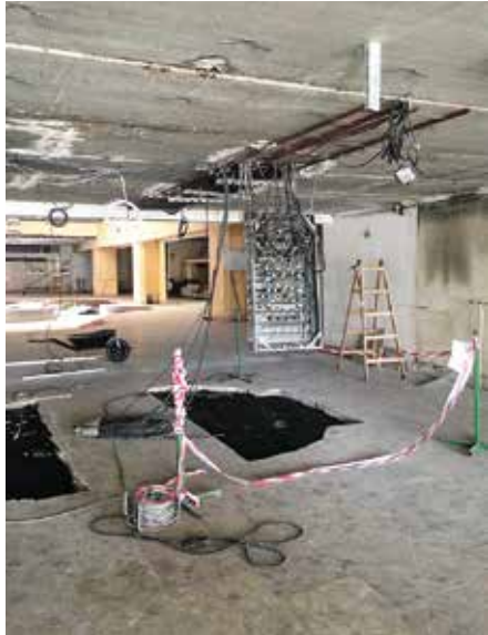
Po rekonštrukcii baletnej sály, sociálnych zariadení pre účinkujúcich či inštalovaní zariadenia na schodoch pre návštevníkov
