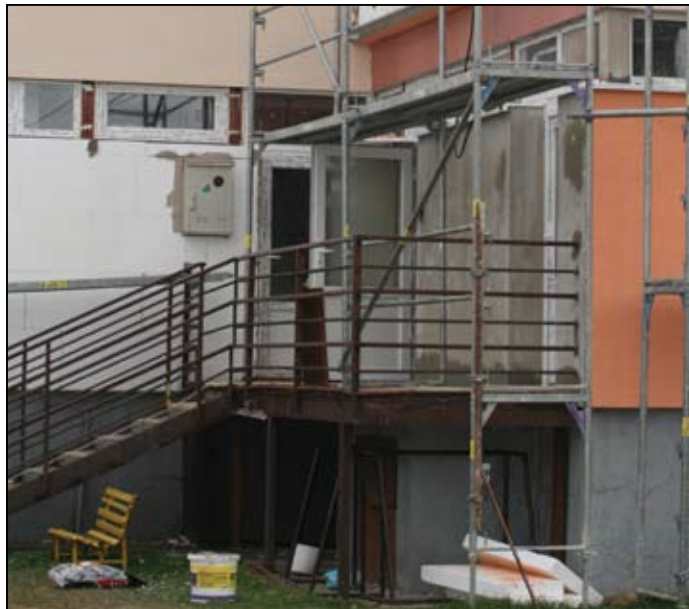
Rekonštrukčné práce sú v plnom prúde. V novembri by sa mali skončiť.
