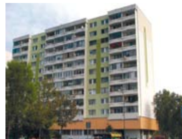
Bytový dom Podzáhradná 45 – 49, 80 bytov dotácia z MVRR: 3 260 000 Sk, dotácia z EBRD: 1 000 000 Sk celkové náklady: 8 842 896 Sk, úver Tatra banka: 5 000 000 Sk ukončenie projektu v roku 2008
