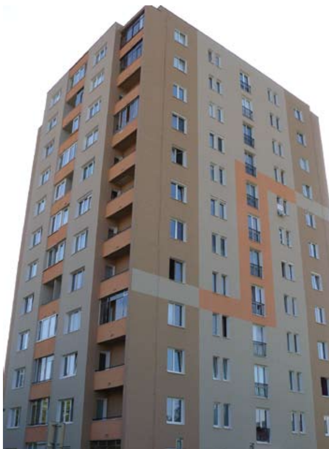
Jeden zo zateplených panelákov v Ružínove.
